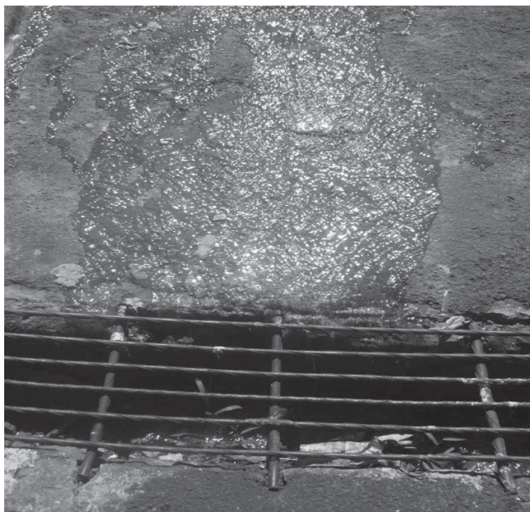
Figura 04: Escoamento da água. Foto: ARFELLI, 2010
