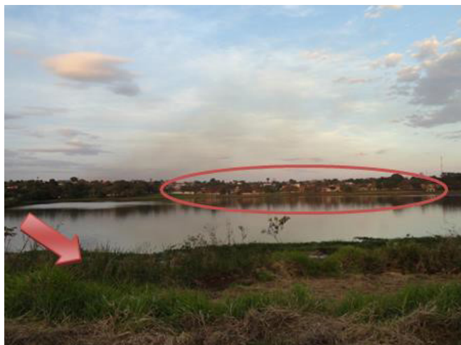
Figura 3. Represa da UHE em Salto Grande (SP), com destaque para os usos e ocupações das APP da represa: urbanização e ausência da mata ciliar.
