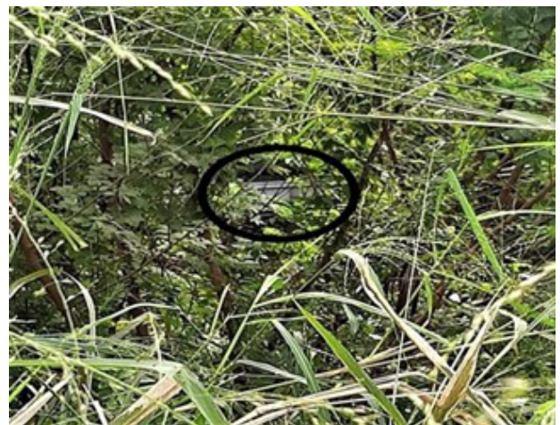
Figura 7 – Poste de eletricidade tombado em área de mata ciliar do ribeirão Tangará.
