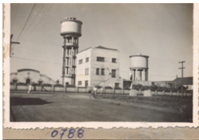
Figura 36. Reservatório de água, Ourinhos, década de 1940.
