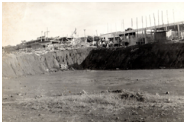
Figura 103. Construção do Centro Social e Urbano (CSU), Ourinhos, 1979-1980.
