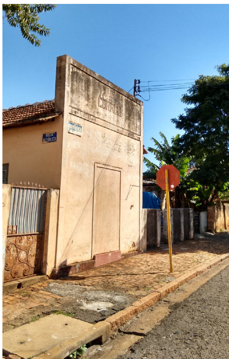
Figura 3. Vista parcial da antiga agência dos Correios, localizada na Vila Odilon.
