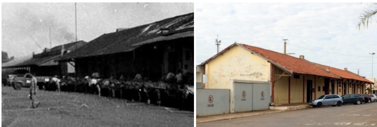
Figura 11. Barracão ferroviário da antiga estação em Ourinhos, na década de 1960. Na época, o espaço ainda pertencia à Estrada de Ferro Sorocabana (EFS), extinta em 1971, ano em que passou a integrar a malha da Fepasa. Por outra perspectiva, já no ano de 2015, com foco no bloco de madeira, a antiga Estação Sorocabana, revitalizada pela PMO e dando lugar ao Núcleo de Arte Popular.
