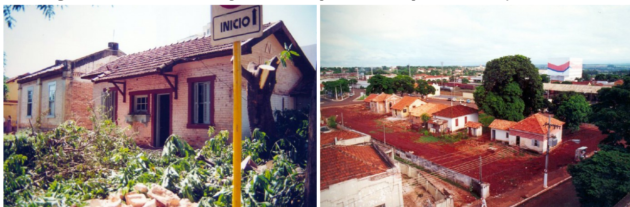
Figura 8. Casas ferroviárias agora vistas em processo de limpeza e restauração. Ano: 1995.
