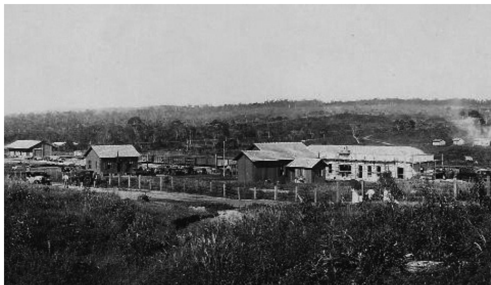
Figura 3. A construção da estação ferroviária de Jacarezinho.
