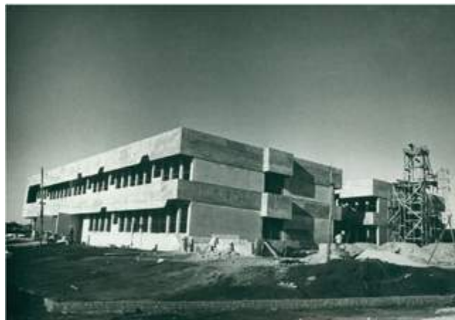
Figura 90. Construção do novo fórum de Ourinhos, 1975-1976.
