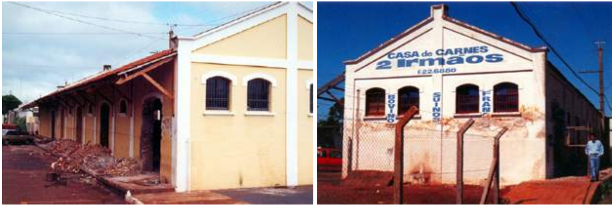
Figura 13. Barracão durante processo de reforma para abrigar o Museu Histórico e Pedagógico de Ourinhos. Suas portas originais, feitas em madeira, foram arrancadas e substituídas por vidro. Ano: 1996.
