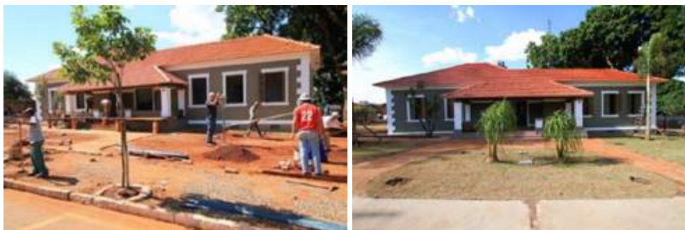
Figura 22. Casa da antiga Companhia Estrada de Ferro São Paulo-Paraná. Membros da Secretaria Municipal de Obras concentrados na fase final de restauração do imóvel. Ano: 2013.
