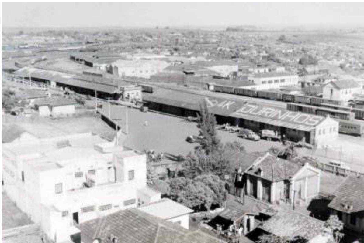
Figura 6. Região central de Ourinhos. Barracão da Estação Ferroviária em destaque. Abaixo, no canto direito da foto, algumas das casas (de um conjunto de seis) que hoje compõem o Centro de Convivência Cultural. Década de 1950.
