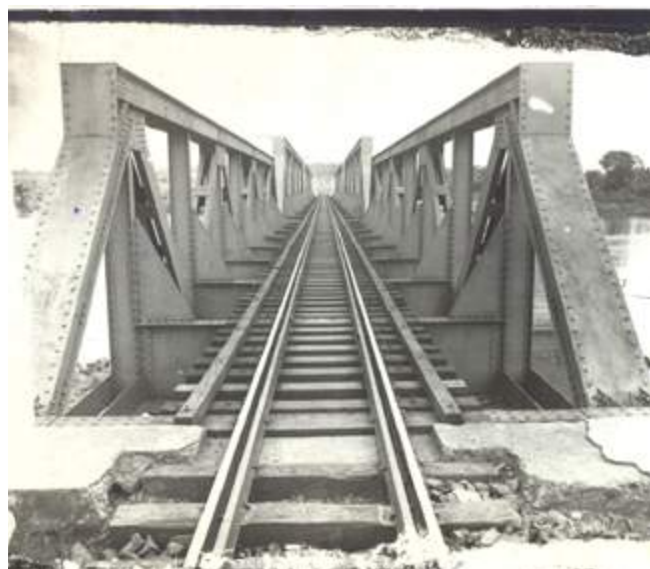
Figura 20. Ponte férrea, Ourinhos, década de 1930.
